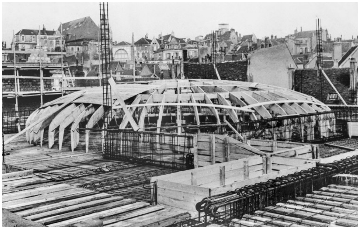
1er tableau : [2C] La coupole en construction, 1938. 89, Auxerre, 56 rue Joubert
