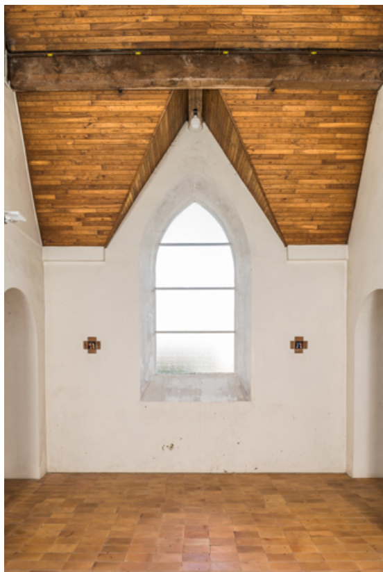
Détail d'une travée.
