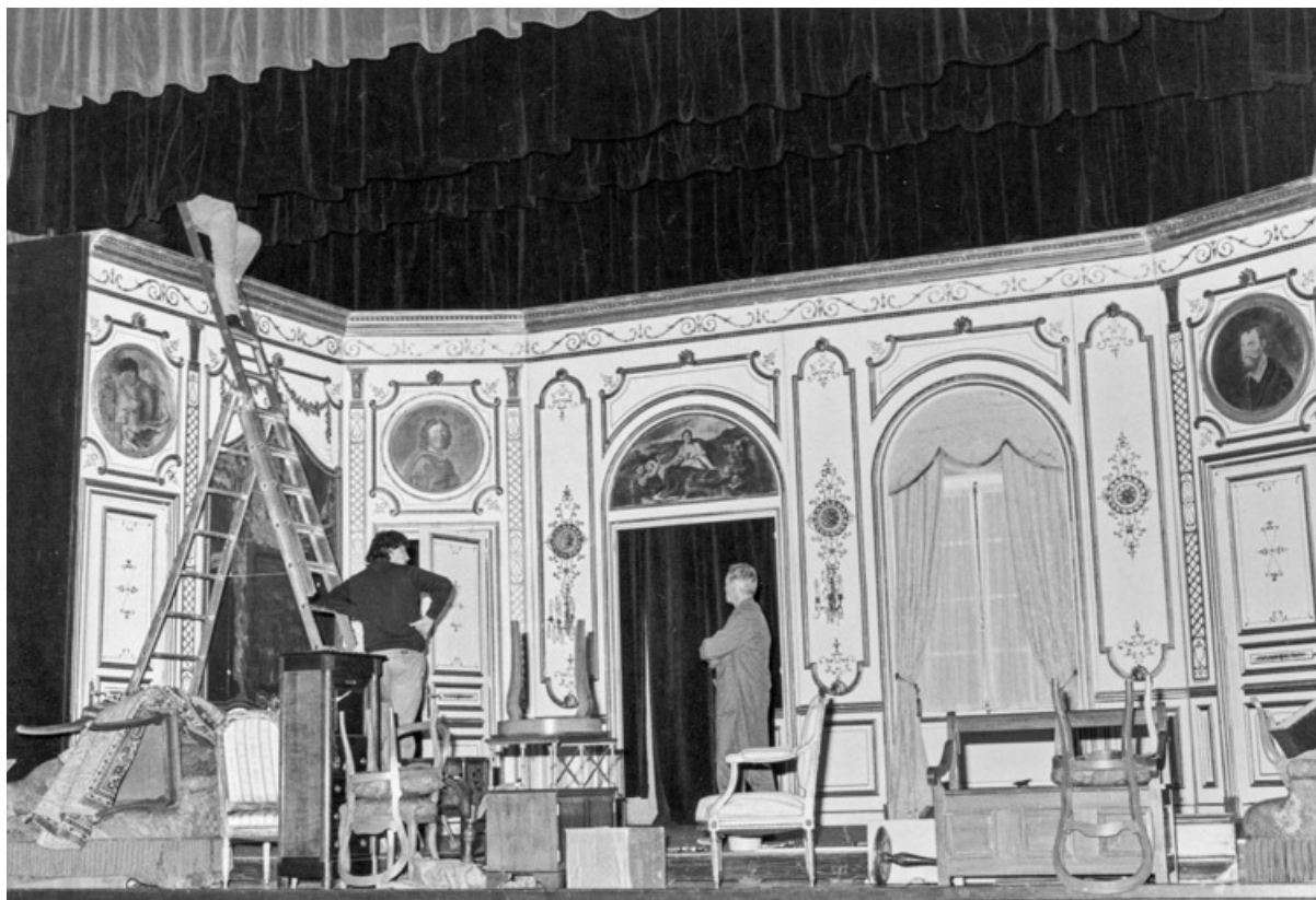
Montage d'un décor]. S.d. [4e quart 20e siècle].
