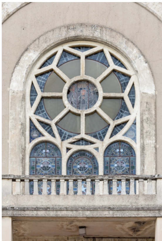
Verrière de la façade ouest. Vue extérieure.
