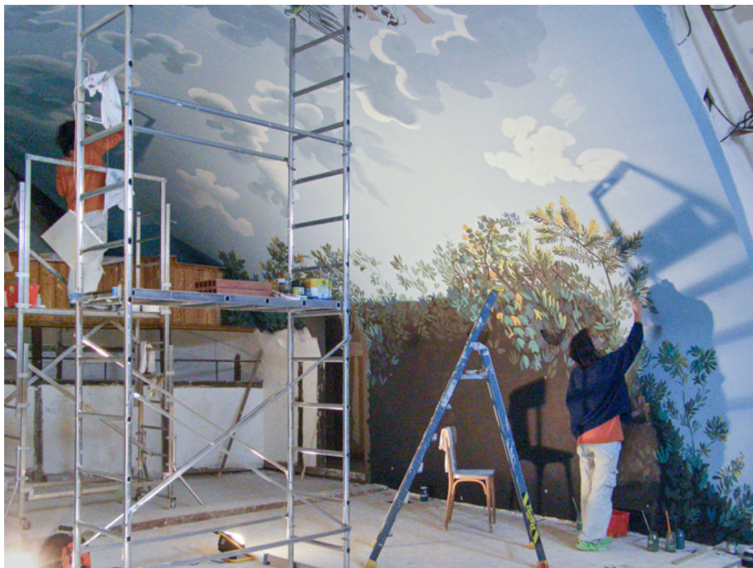
[Réfection des peintures de la voûte : restauratrices]. 2008.
