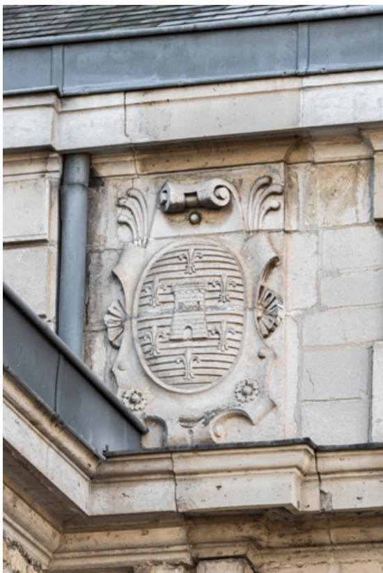
Façade latérale gauche, attique : armoiries de la ville. 89, Sens, 1-2 boulevard des Garibaldi
