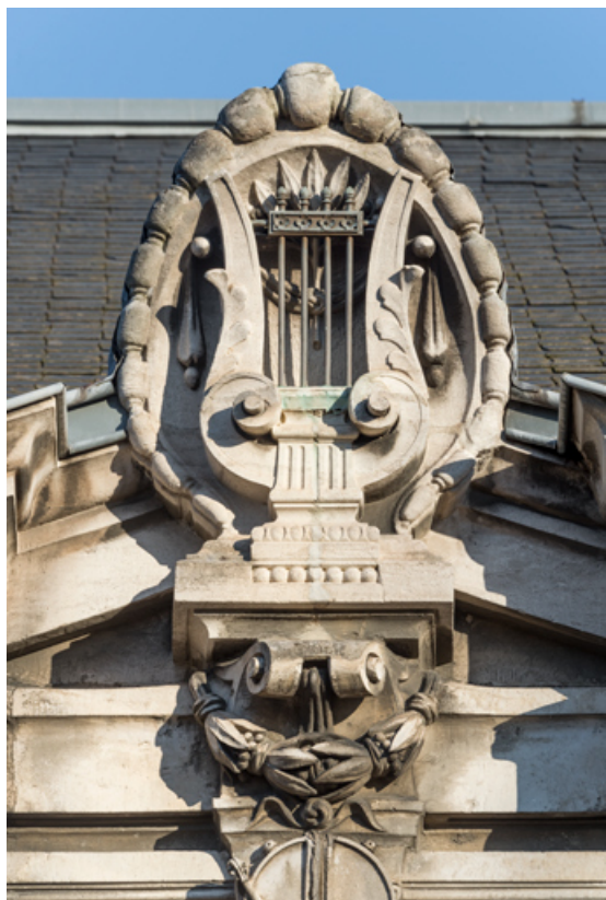
Façade latérale droite, attique : amortissement de la travée centrale. 89, Sens, 1-2 boulevard des Garibaldi
