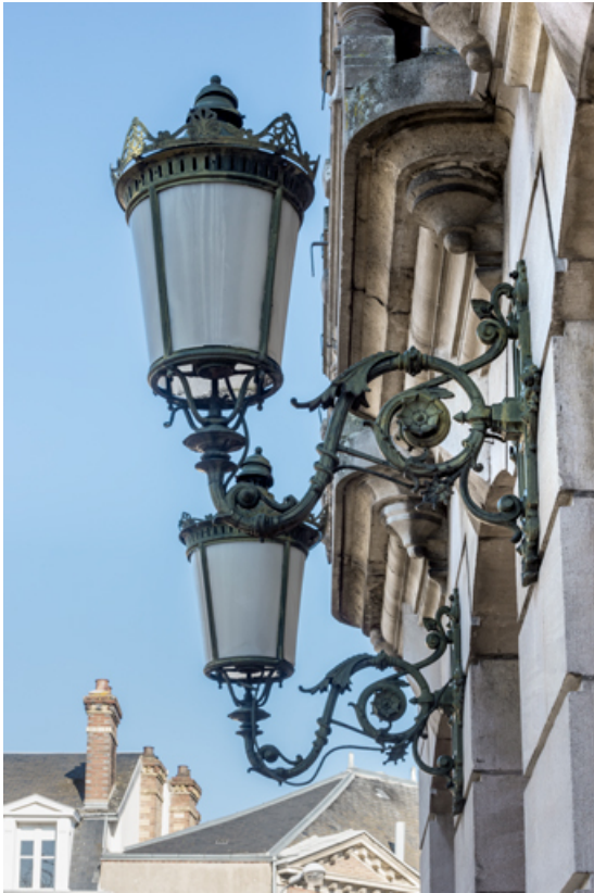
Luminaires d'applique en façade, vus de profil.
