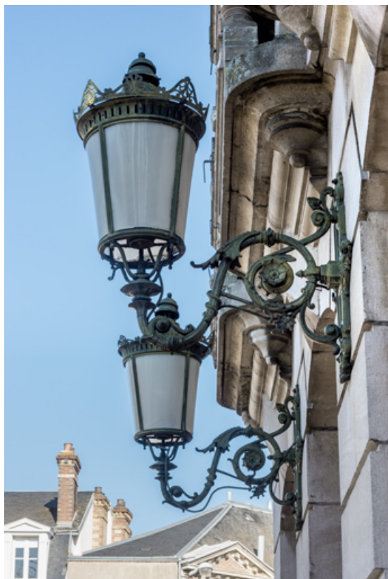
Luminaires d'applique en façade, vus de profil.
