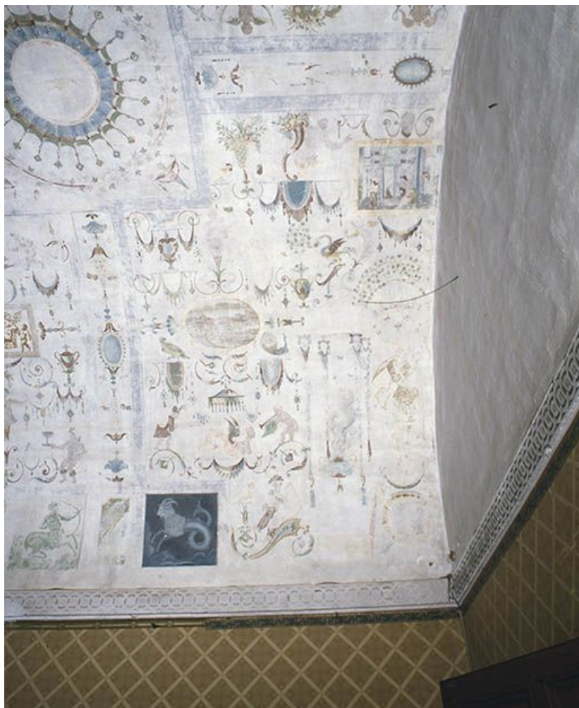
Chambre du Zodiaque, voûte, partie nord-est, vue générale 89, Ancy-le-Franc château
