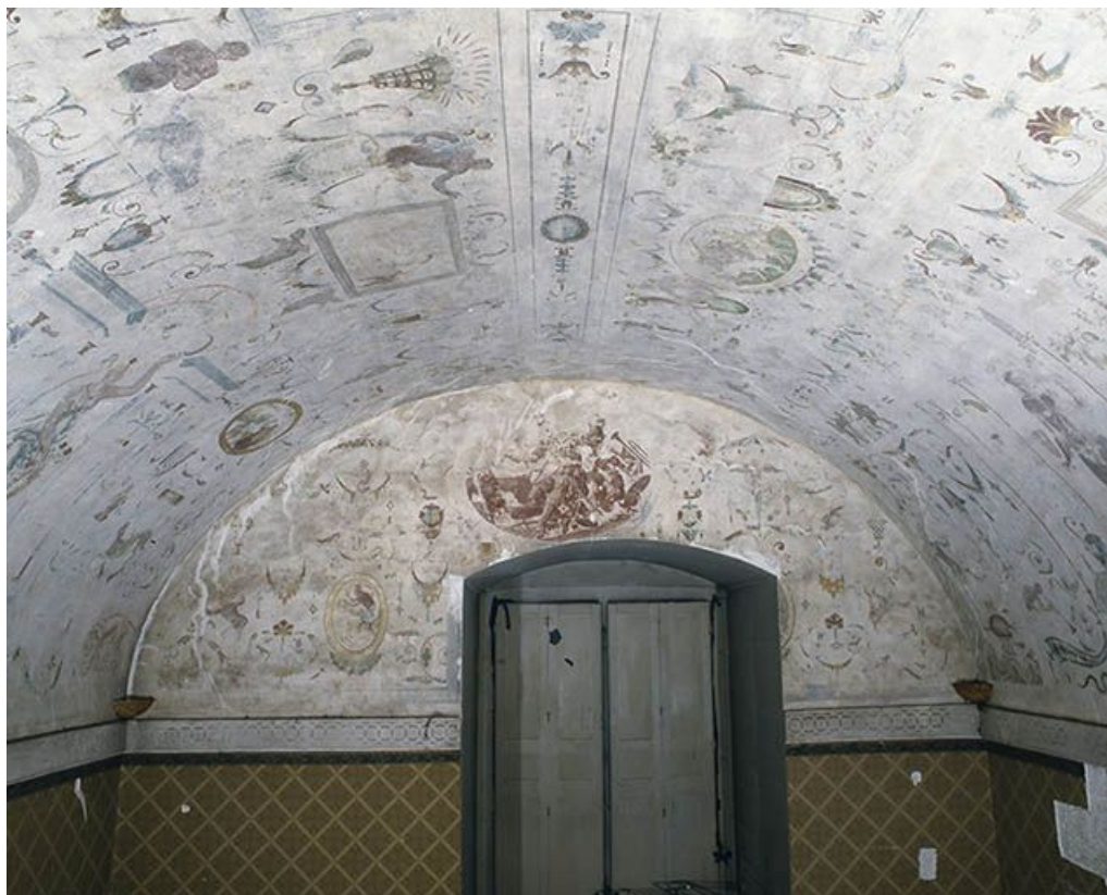
Chambre du Zodiaque, mur ouest, vue générale 89, Ancy-le-Franc château
