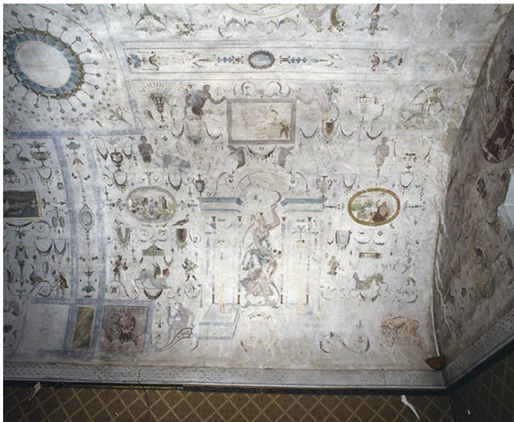
Chambre du Zodiaque, voûte, partie sud-ouest, vue générale
