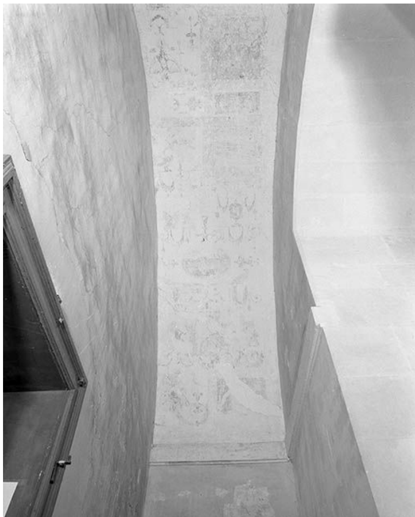
Chambre du Zodiaque, couloir, voûte, partie nord 89, Ancy-le-Franc château
