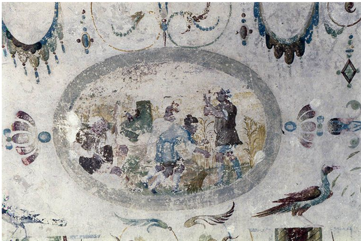
Chambre du Zodiaque, voûte, partie sud-ouest, l'Eté 89, Ancy-le-Franc château
