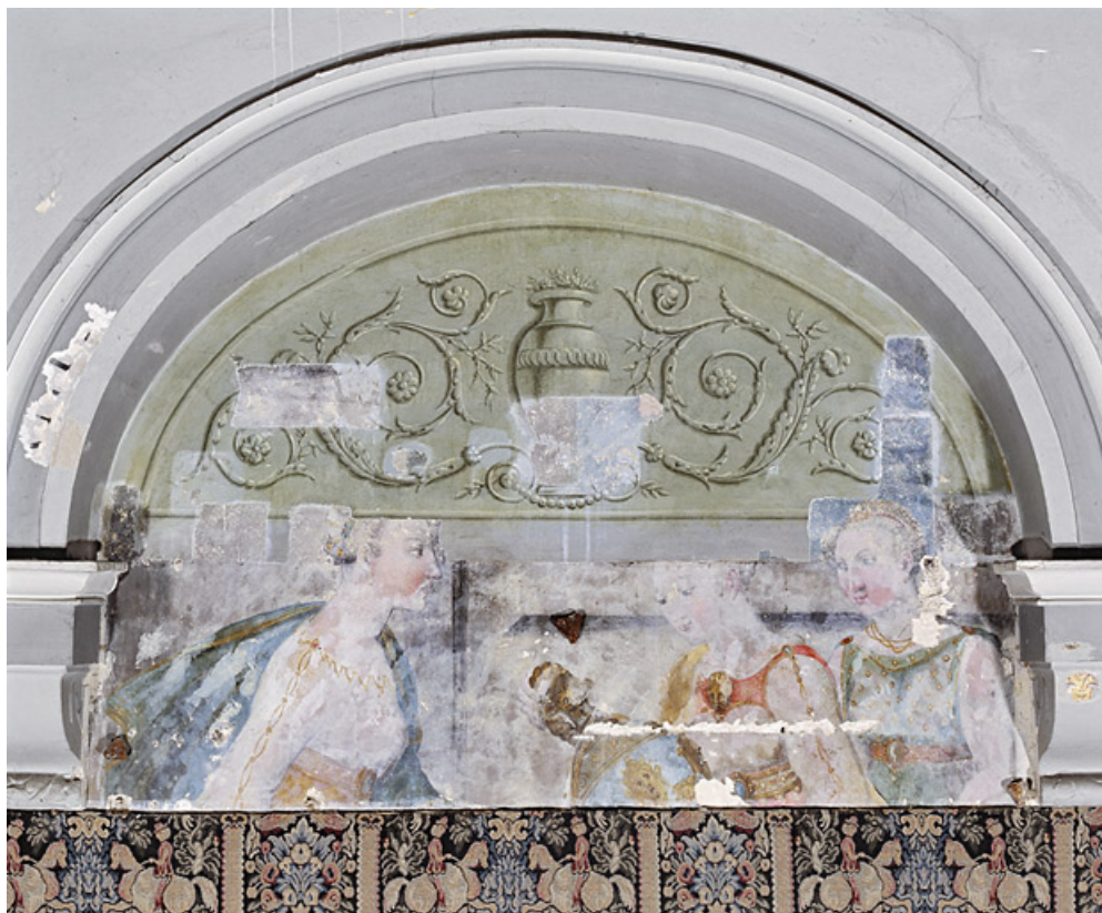
Chambre de l'Aigle, mur nord, partie ouest 89, Ancy-le-Franc château
