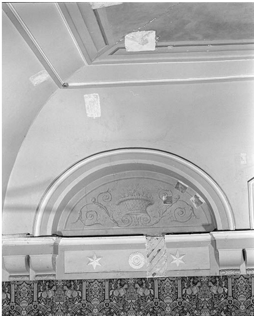
Chambre de l'Aigle, mur est, partie nord 89, Ancy-le-Franc château
