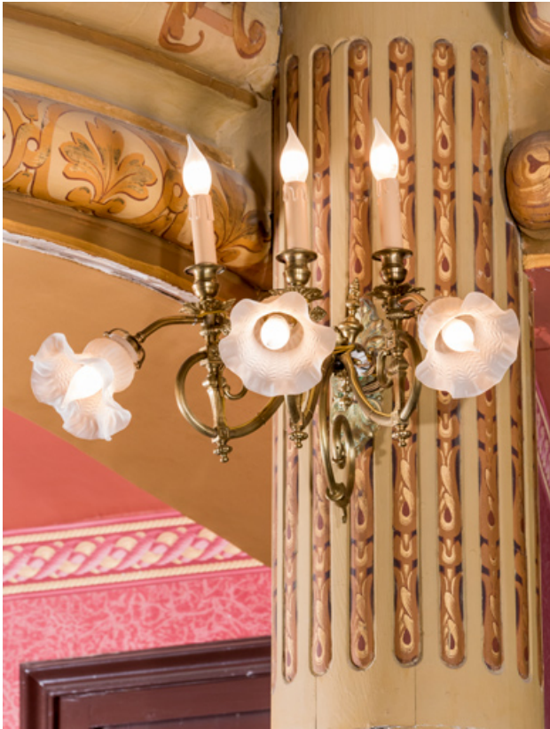
Salle : luminaire d'applique (cadrage vertical). 71, Autun place du Champ de Mars
