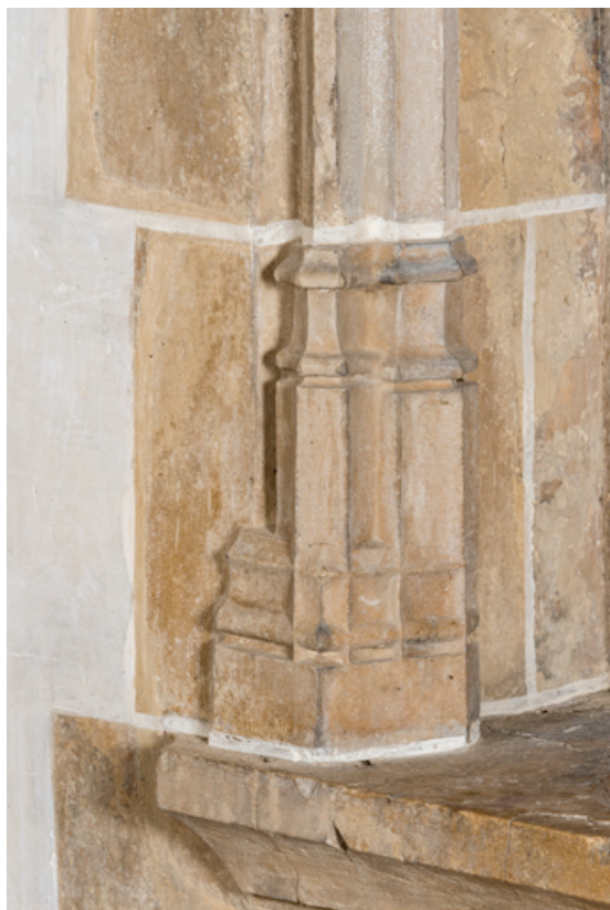
Détail : bases prismatiques des piédroits.
