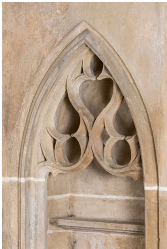
Détail : remplage de l'arc.
