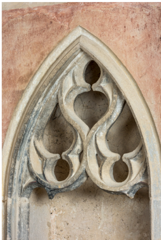
Détail : remplage de la partie supérieure.
