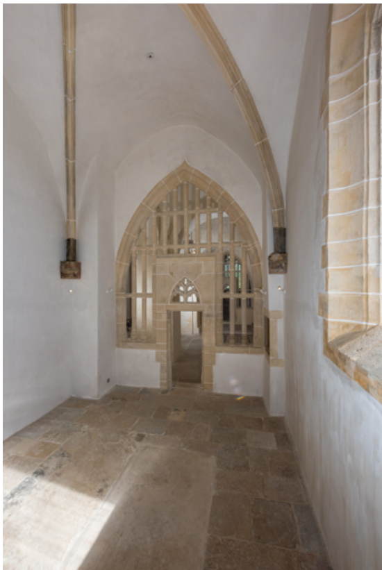
Vue intérieure de chapelle vers le nord.
