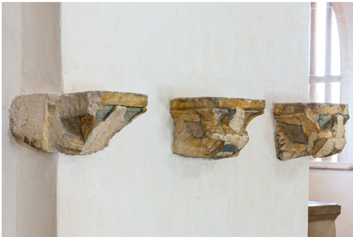
Vue d'ensemble des trois culots surmontant l'autel (vue de trois quarts depuis la gauche).
