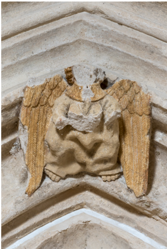
Détail : ange porteur d'écu de la voussure. 71, Laives, lieudit : Montagne de Saint-Martin
