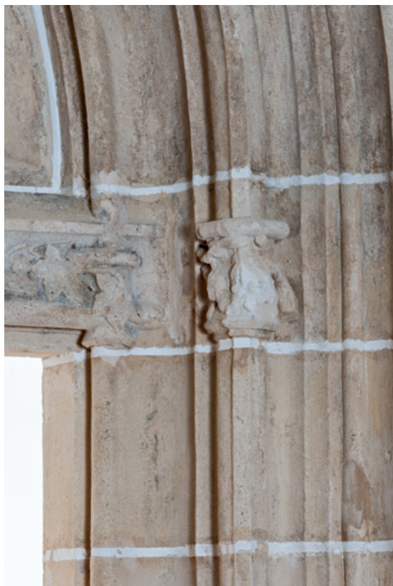
Détail : piédroit, partie supérieure.
