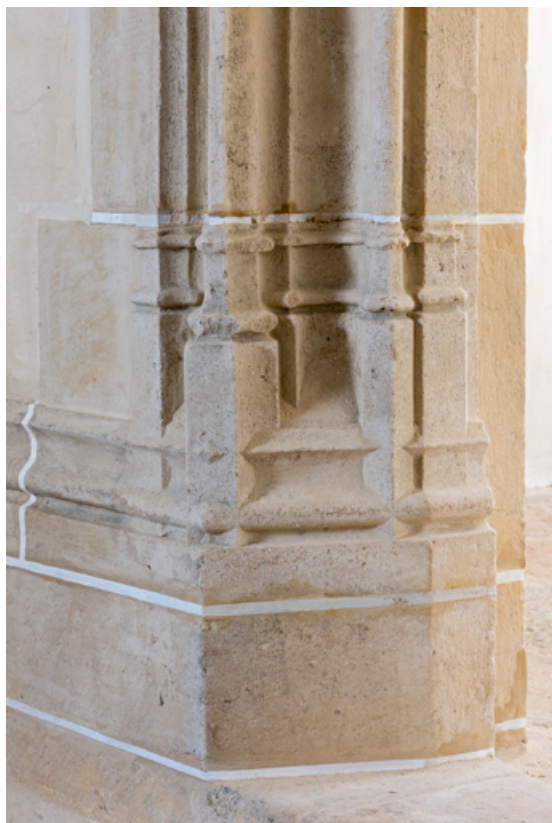
Détail : piédroit, partie inférieure.
