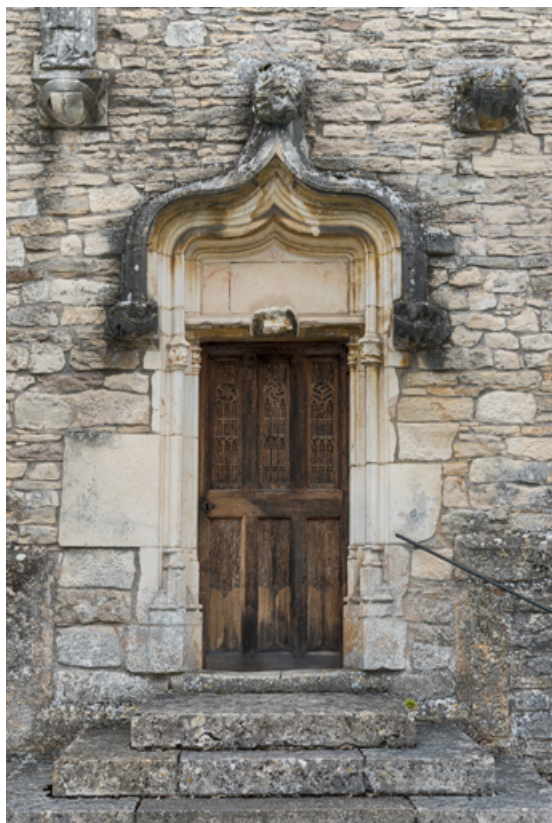
Porte en façade occidentale (vantaïl fermé). 71, Laives montée de Lenoux, lieudit : Lenoux
