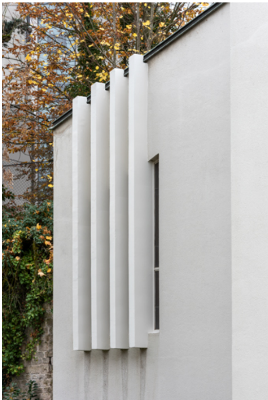
Détail de la baie de la façade est (baie 3).
