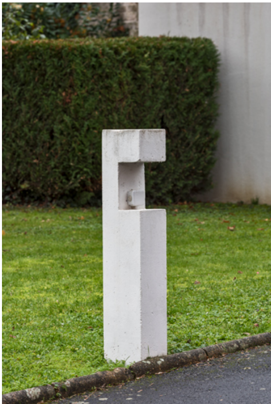
Détail d'une borne lumineuse.
