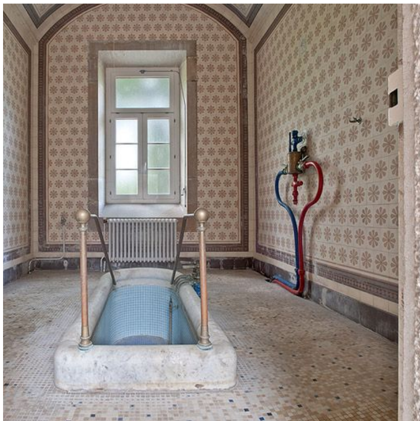
Salle de bain au centre de l'aile gauche.
