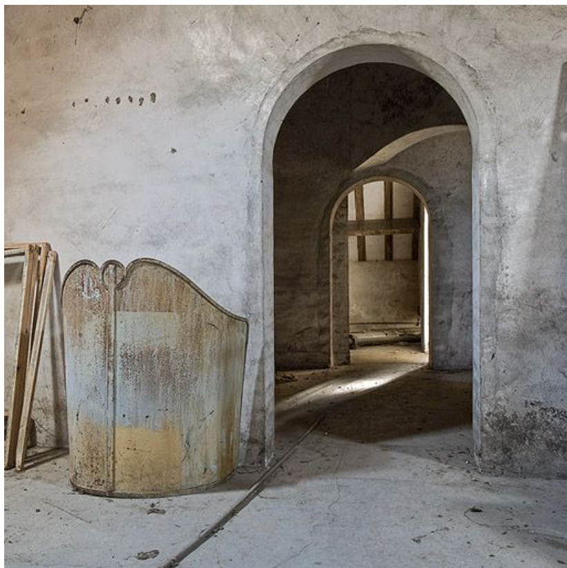
Comble : partie droite du corps central.
