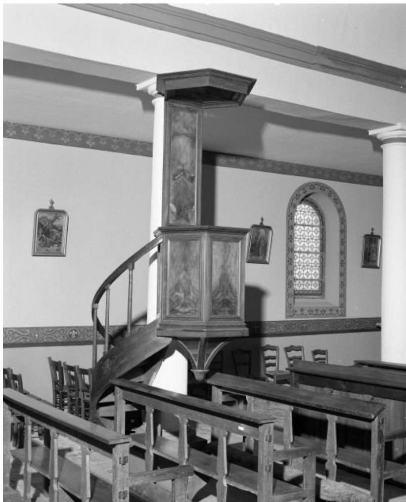
Vue d'ensemble. 71, Pontoux Eglise
