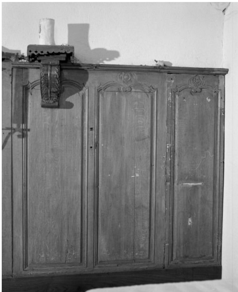
Lambris de demi-revêtement : panneaux, mur gauche, au fond. 71, Charnay-lès-Chalon Forge
