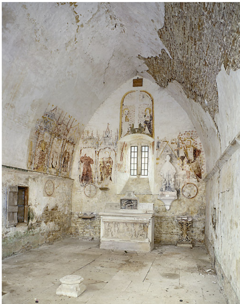
Vue d'ensemble de la chapelle.
