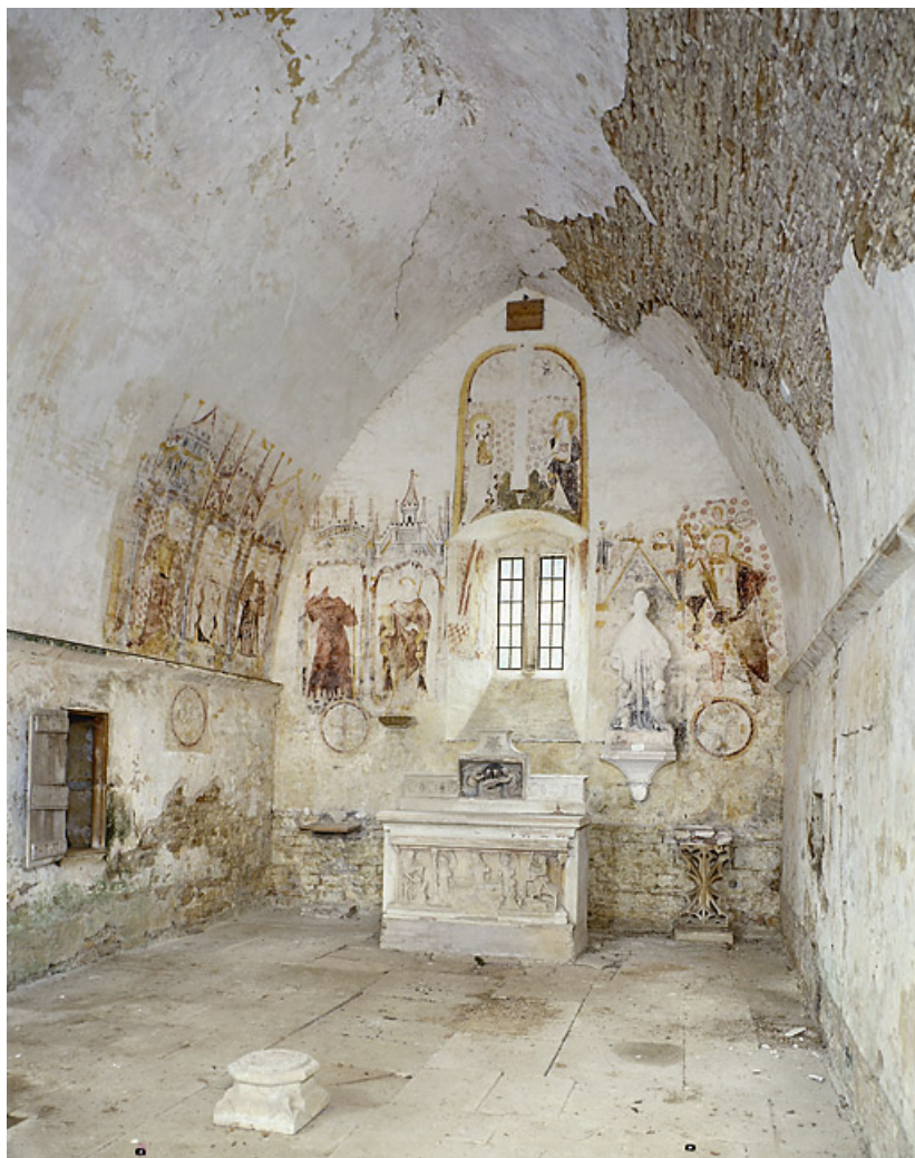
Vue d'ensemble de la chapelle.
