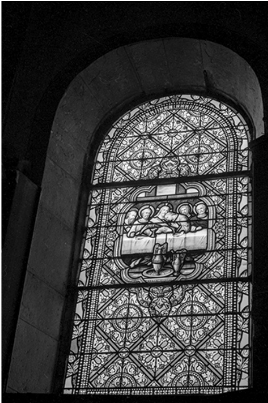
Baie 1 : vue d'ensemble.
