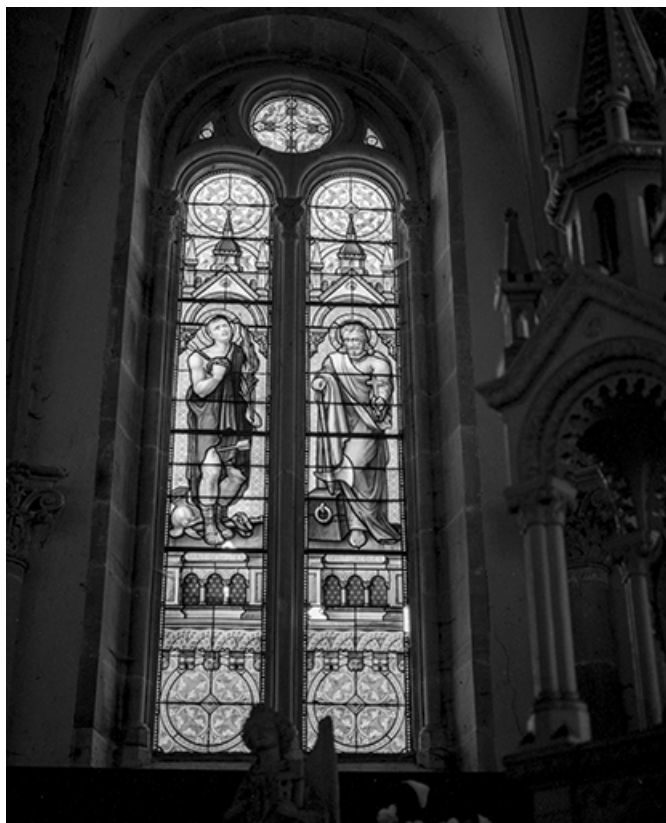
Baie 1 : vue d'ensemble.
