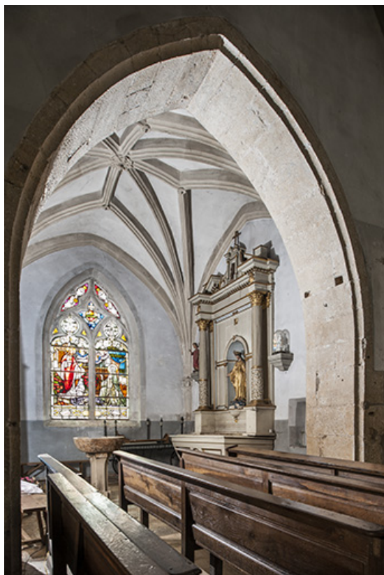
La chapelle latérale nord et sa voûte à nervures multiples. 70, Purgerot Grande Rue
