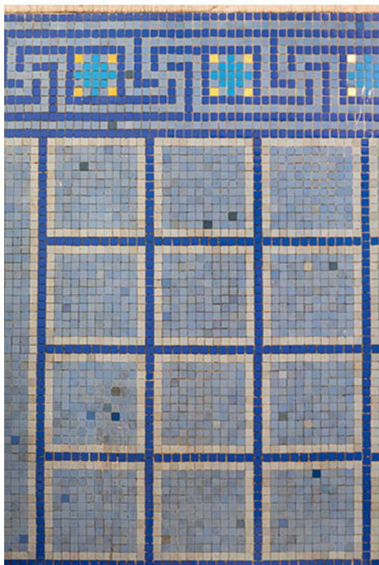
Mur nord de la dernière cabine (actuellement, local de stockage) au rez-de-chaussée de l'aile à l'est de la piscine. 70, Luxeuil-les-Bains, 3 rue des Thermes
