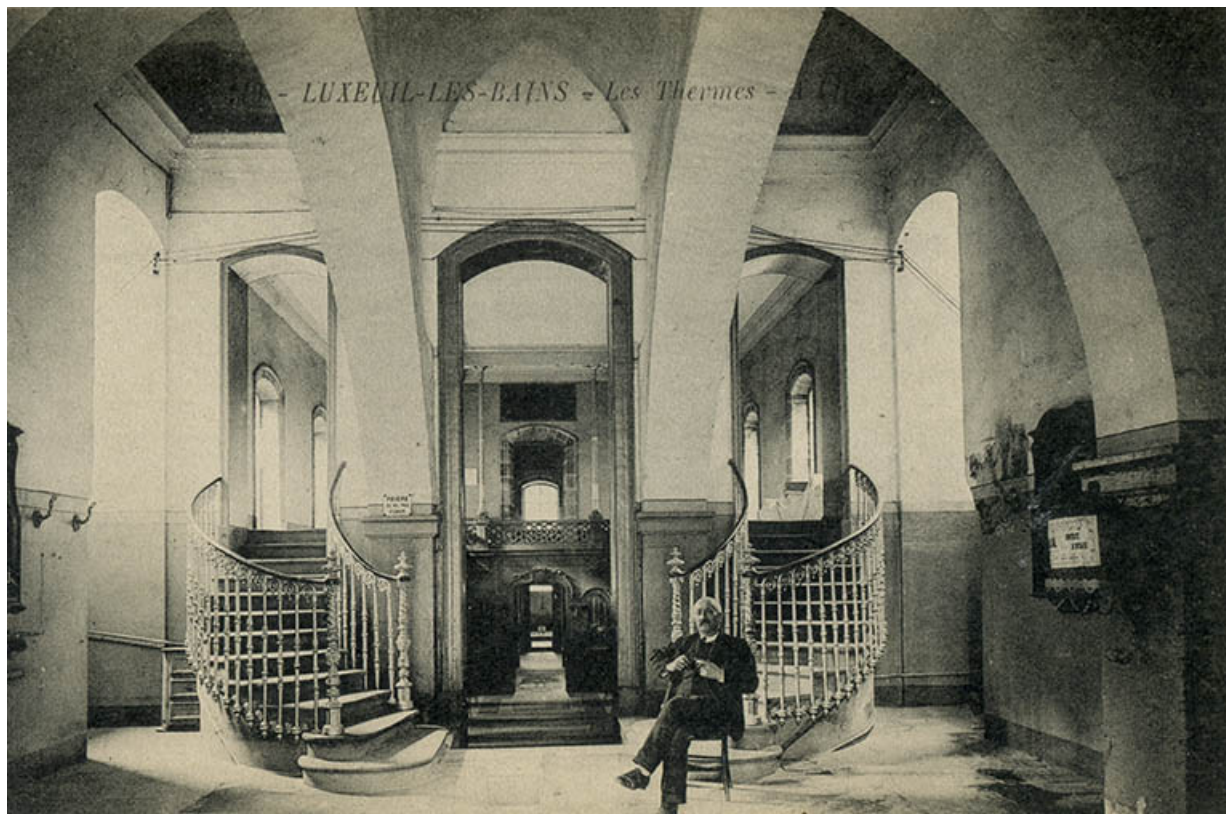
Vue d'ensemble avec le couvrement du vestibule, avant l'exécution du décor. 70, Luxeuil-les-Bains, 3 rue des Thermes
