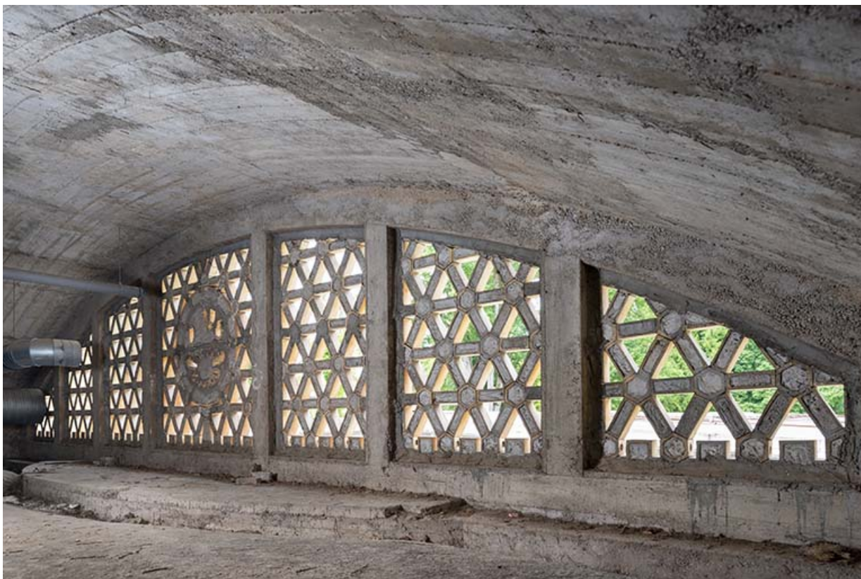
Vue de trois-quarts de la claustra depuis les combles.
