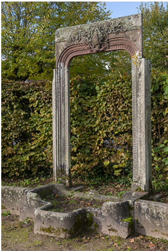
Encadrement de porte, vue de trois-quarts.
