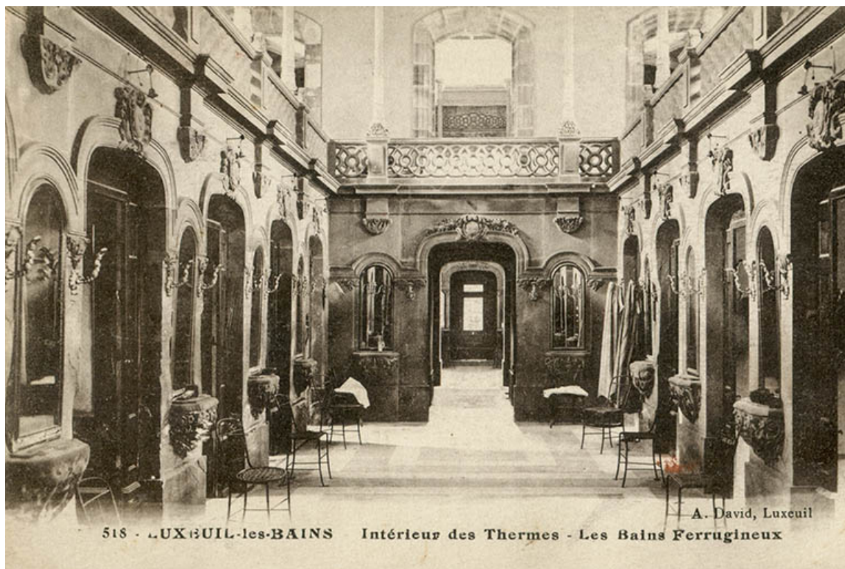
Vue intérieure du Bain ferrugineux détruit à la fin des années 1930.
