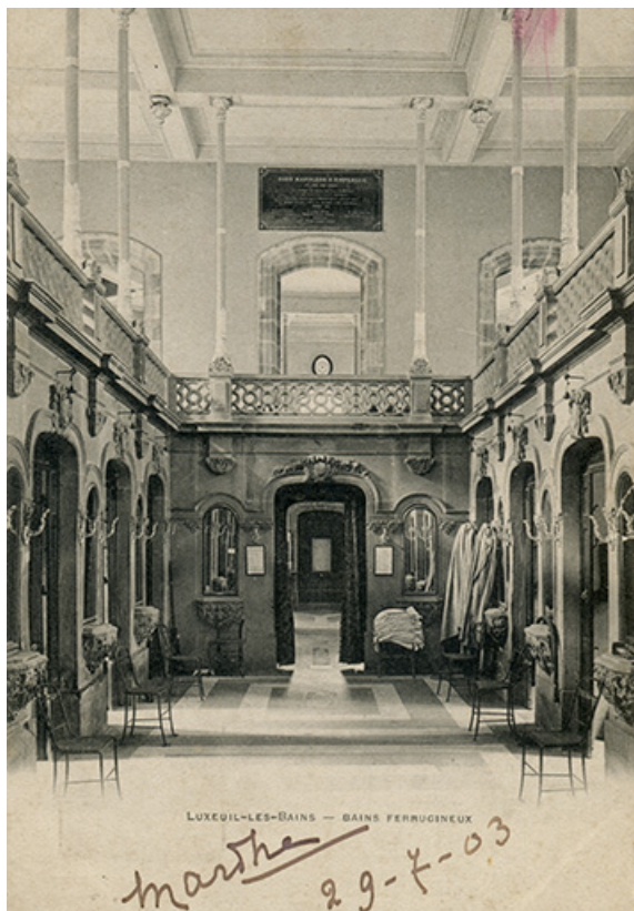
Vue intérieure du Bain ferrugineux détruit à la fin des années 1930.
