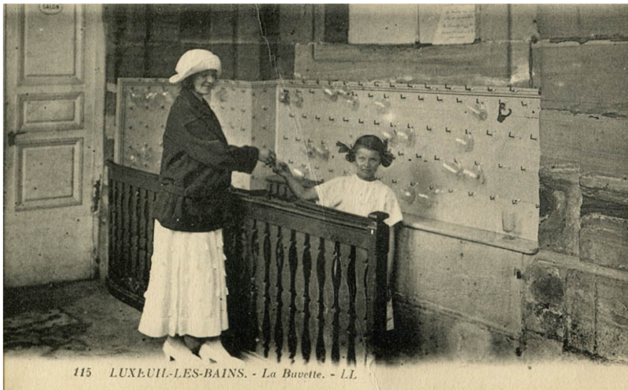
Buvette à l'extrémité ouest de la galerie ouverte du bâtiment nord dit du Grand Bain.
