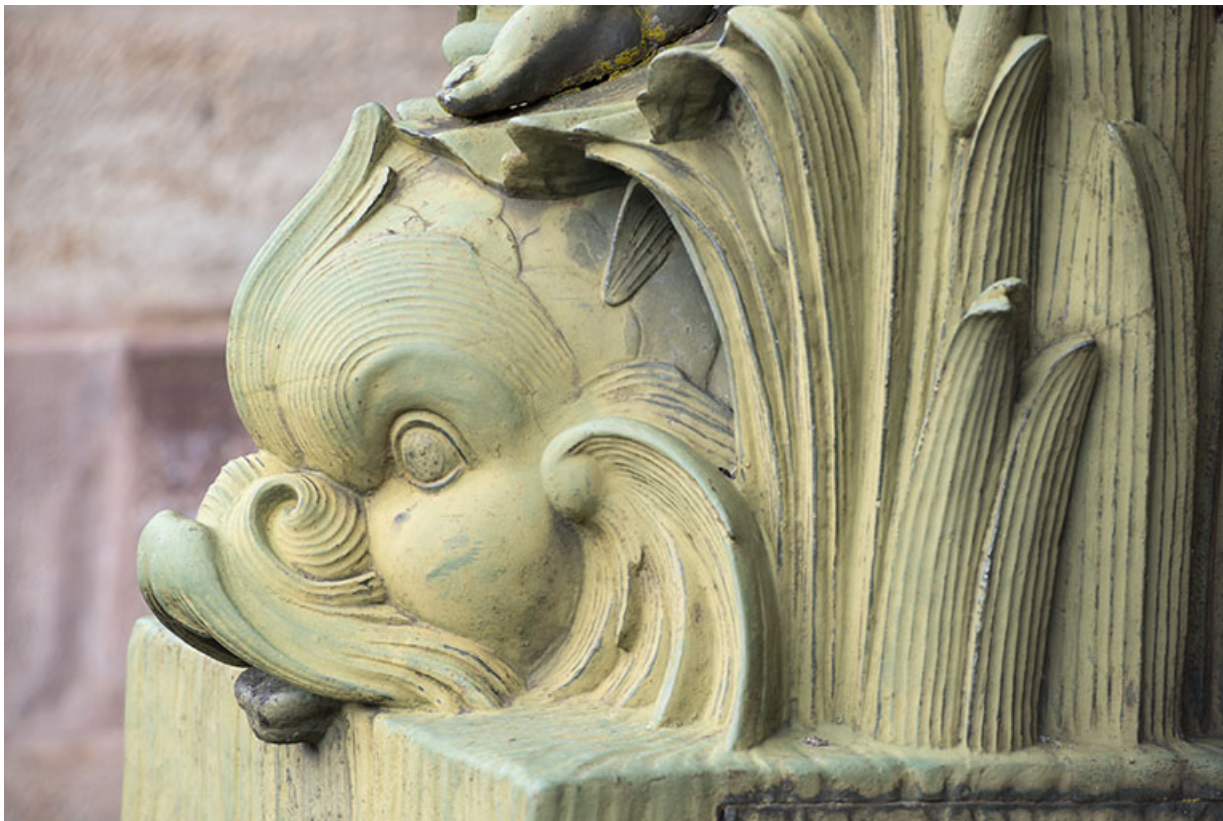
Fontaine du côté droit (est) : vue de la partie supérieure, détail du dauphin. 70, Luxeuil-les-Bains, 3 rue des Thermes
