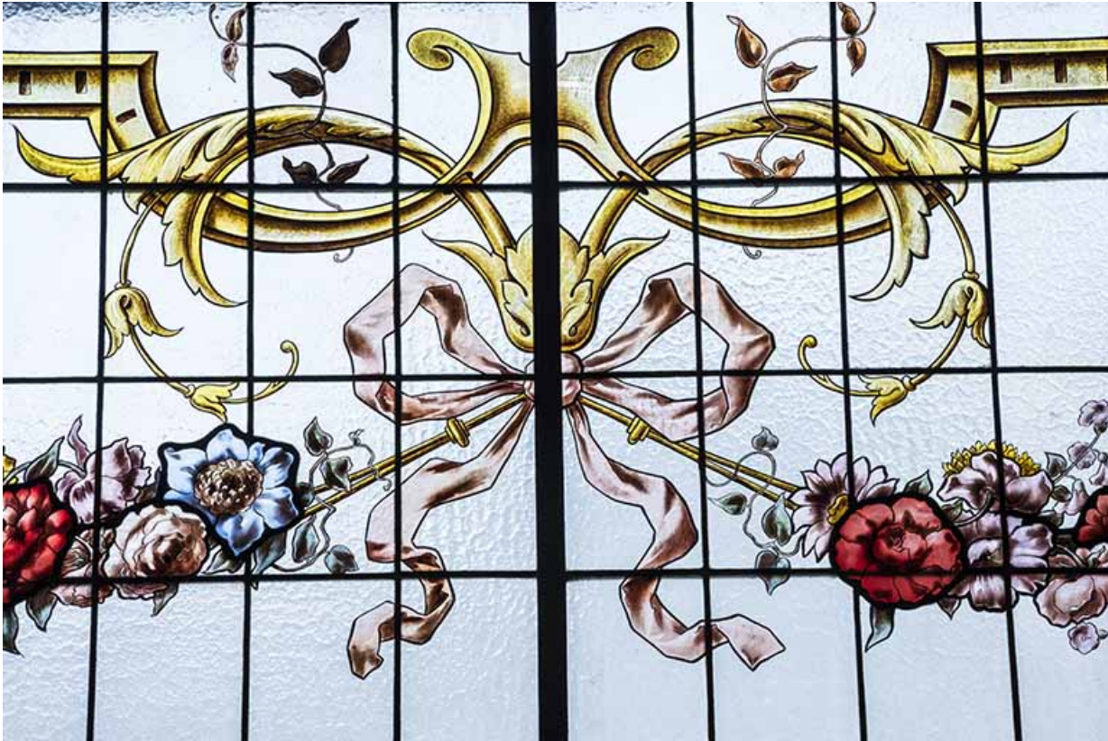
Verrière côté rue, détail : le nœud plat reliant les deux guirlandes à fleurs.
