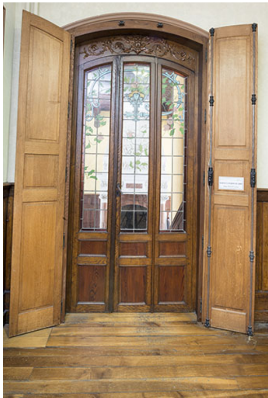
Porte à trois vantaux conduisant à la salle de bal (ou de musique).
