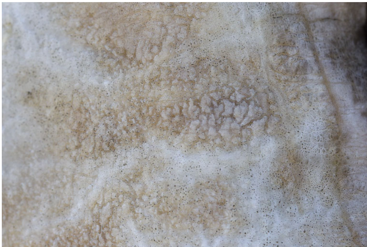
Auguste : altération de l'albâtre.
