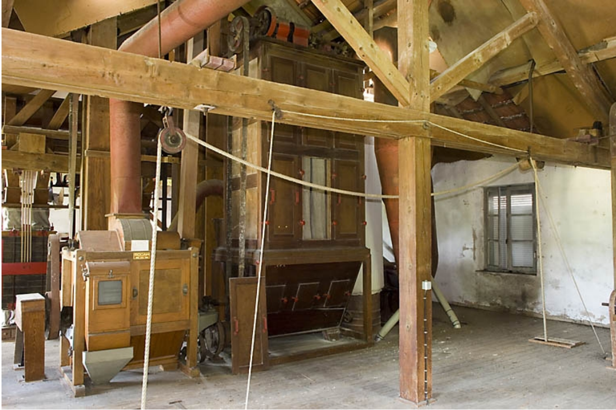
Troisième étage. Brosse à blé Socam et système d'aspiration centrale des Anciens Ets Schneider-Jacquet et Cie. 70, Fougerolles, lieudit : Fougerolles-le-Château
