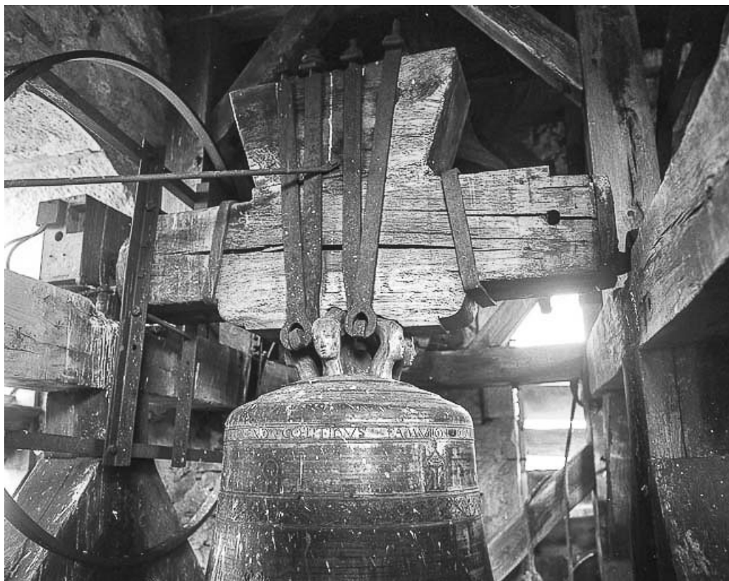
Vue de la partie supérieure.
