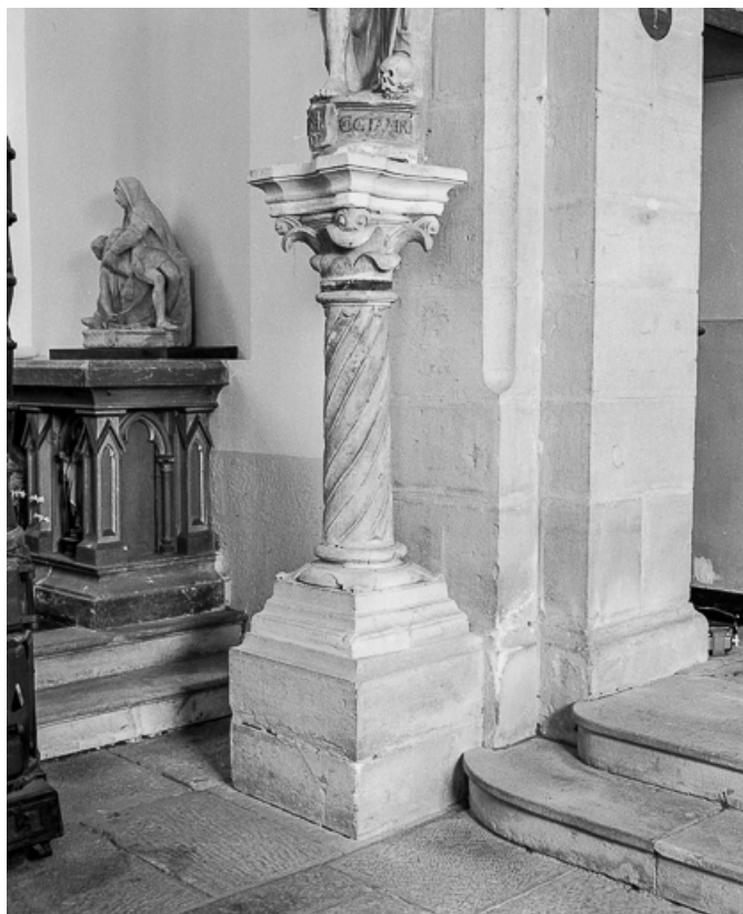
Détail de la colonne.
