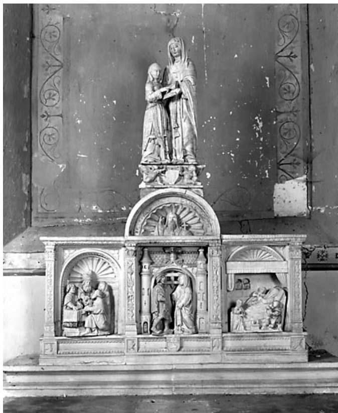
Vue générale. 70, Étuz
