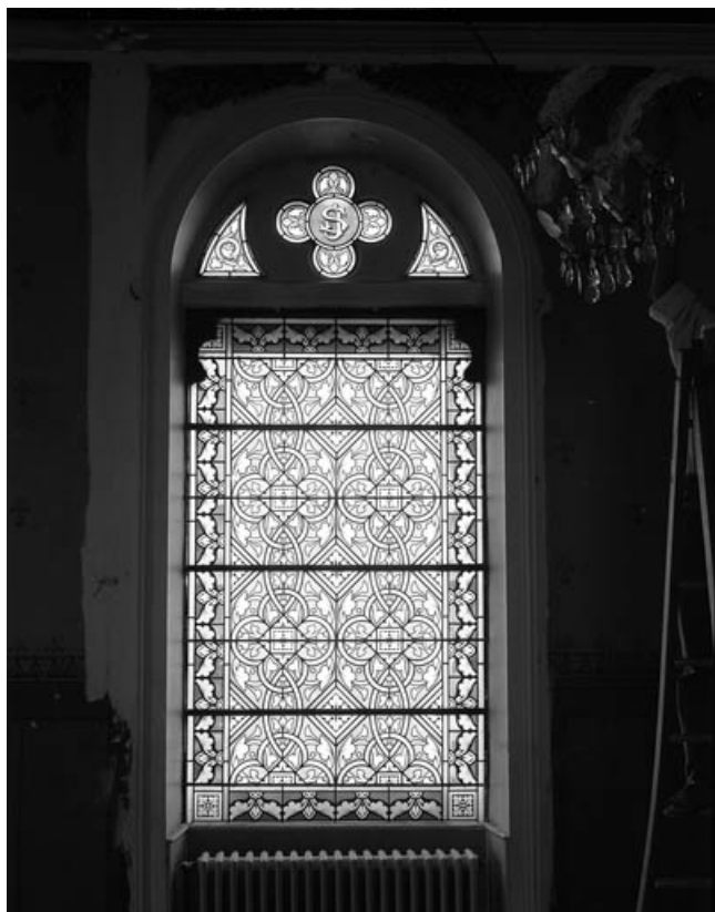
Mur nord : vitrail géométrique (baie 0).
