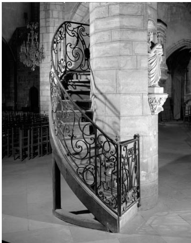
Vue d'ensemble de l'escalier en ferronnerie.
