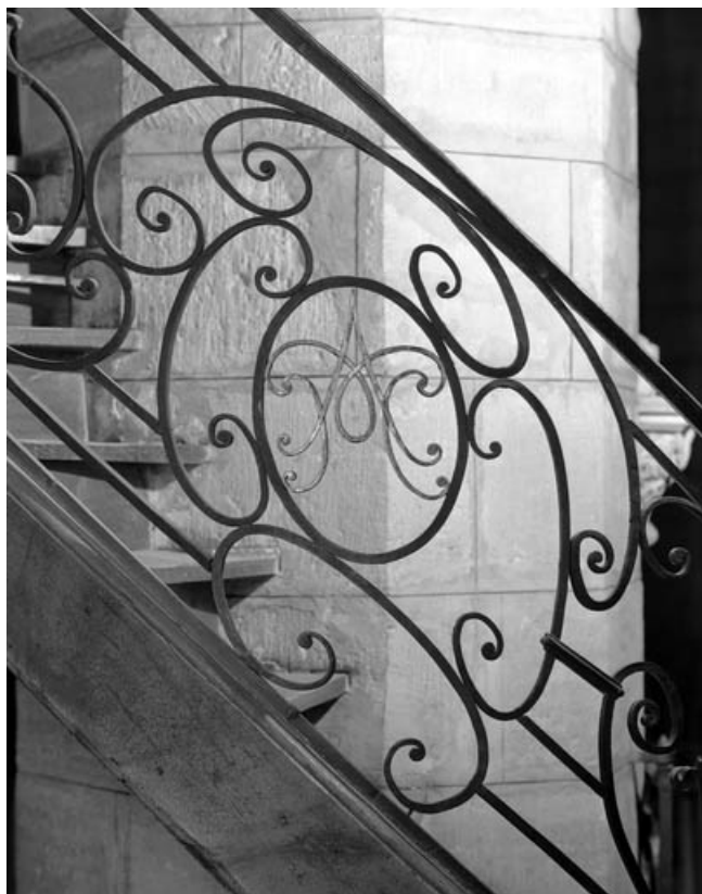
Détail de la ferronnerie de l'escalier avec monogramme de la Vierge.
