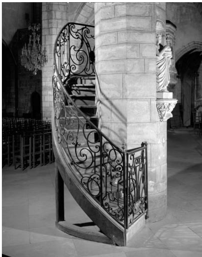
Vue d'ensemble de l'escalier en ferronnerie.
