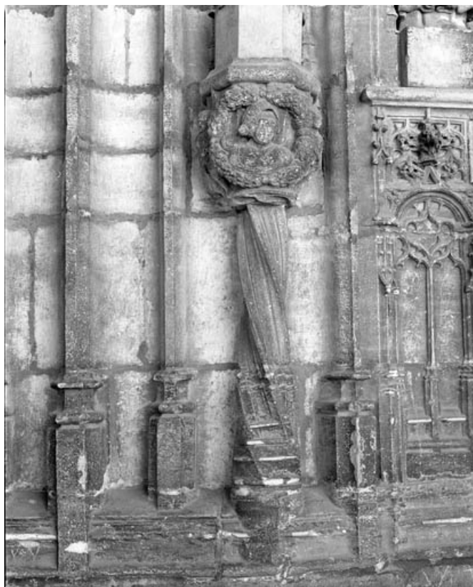
Premier bas-relief droit : allégorie de la vertu, vue d'ensemble. 70, Gray place de la Sous-Préfecture
