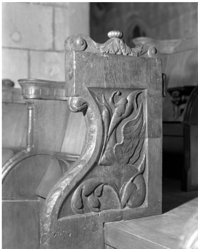
Stalles gauches : détail d'une jouée basse est (B). 70, Gray place de la Sous-Préfecture
