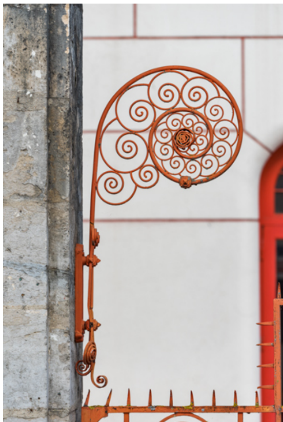
Élément en forme de volute sur le poteau de gauche (vue rapprochée).
