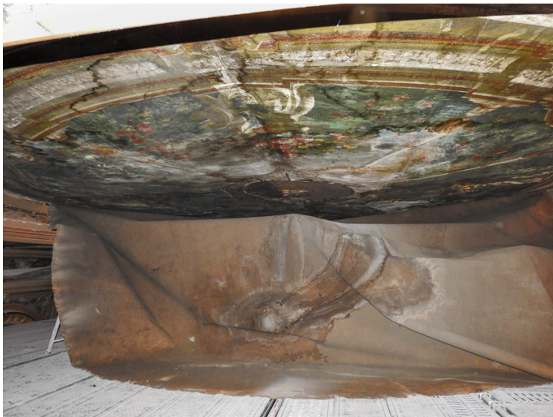
[Vue d'ensemble du tondo, lors de la dépose de celui de Vernon]. S.d. [12 juillet 2017].
