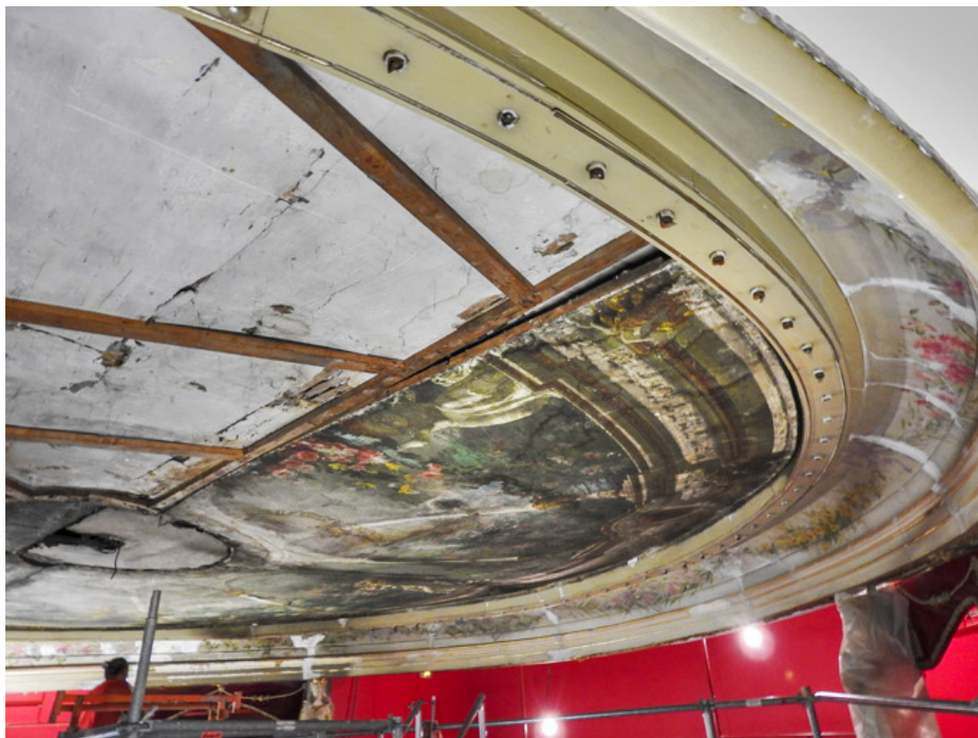
[Tondo en cours de dépose : une moitié a été enlevée]. S.d. [2e semestre 2017].
