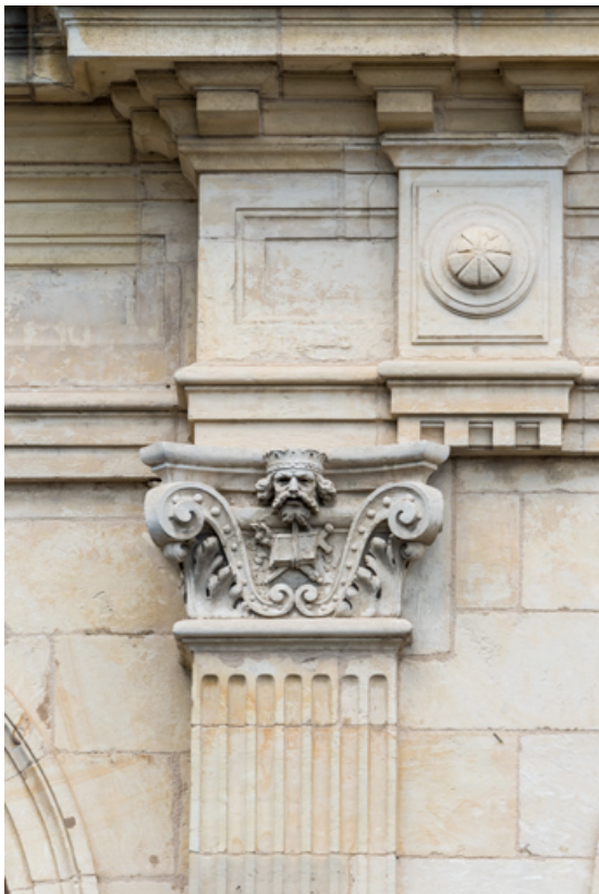
3e pilastre à l'étage carré, chapiteau : une tête.
