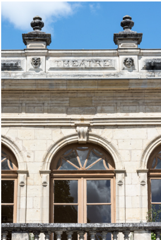
Travée centrale de la façade, à l'étage carré.
