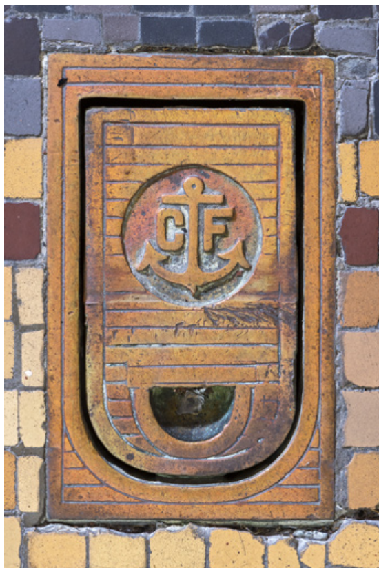
Grille séparant le hall du public et l'antichambre de la salle du conseil, battement (modèle n° 408 de la manufacture Camion Frères). 58, Nevers, 6B rue Jean Desveaux
