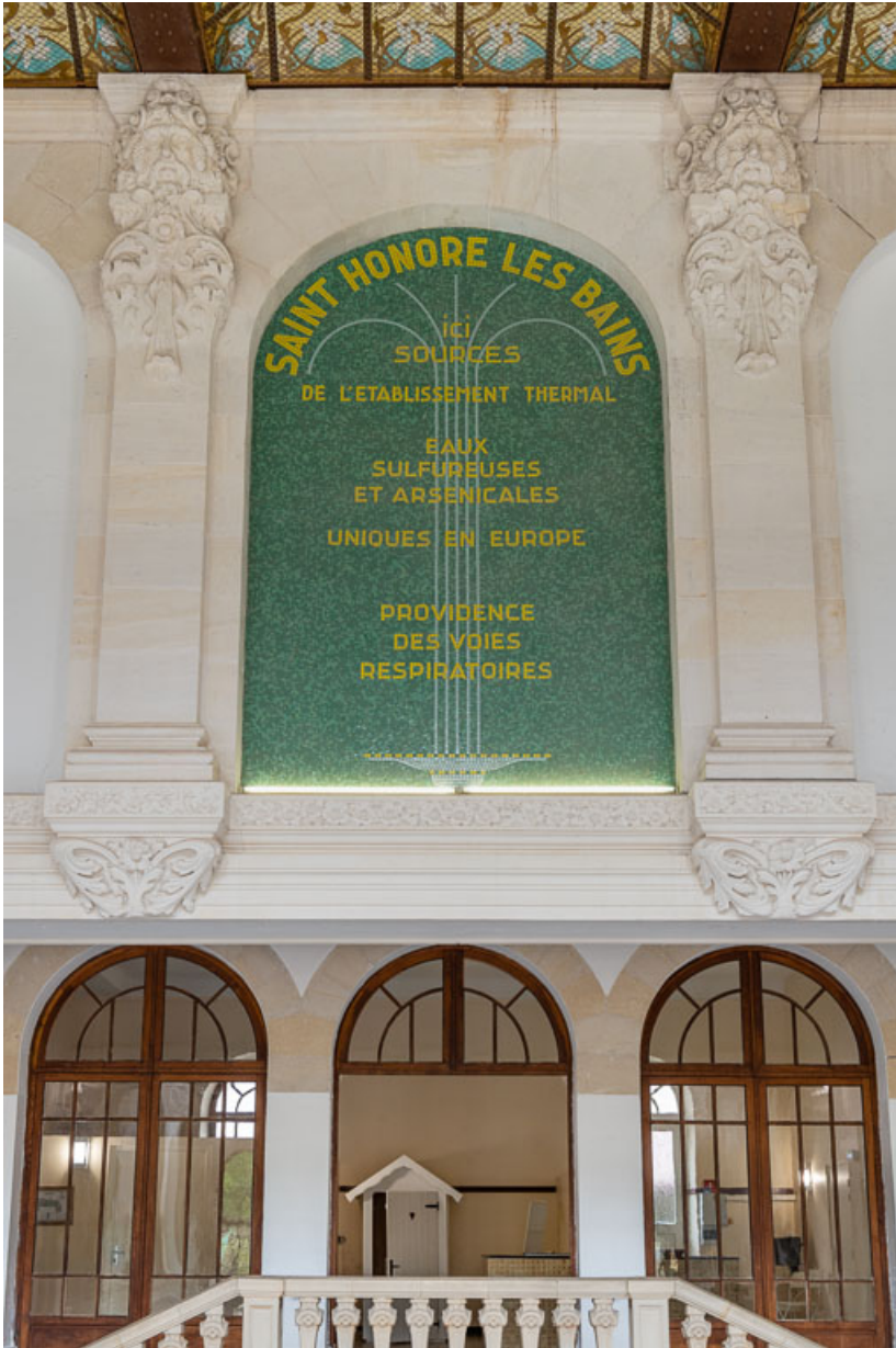
Vue d'ensemble depuis le centre du hall.
