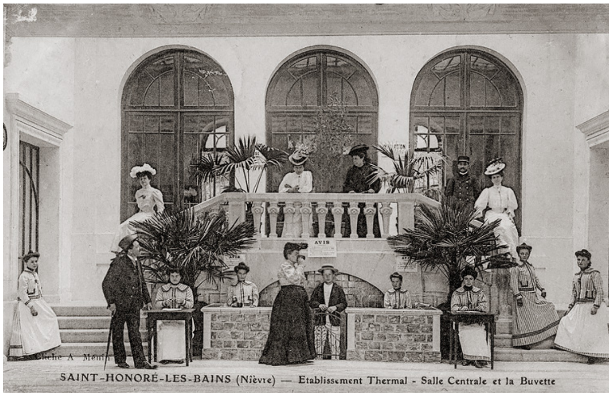
Hall des sources, buvette (état dans les années 1910). 58, Saint-Honoré-les-Bains avenue du Docteur Segard
