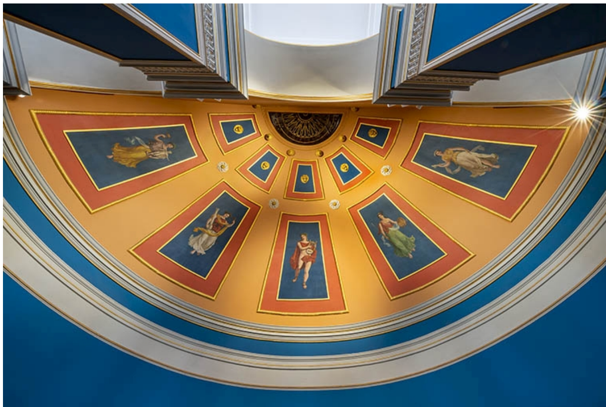
Vue d'ensemble des peintures sur la fausse-voûte en cul-de-four.
